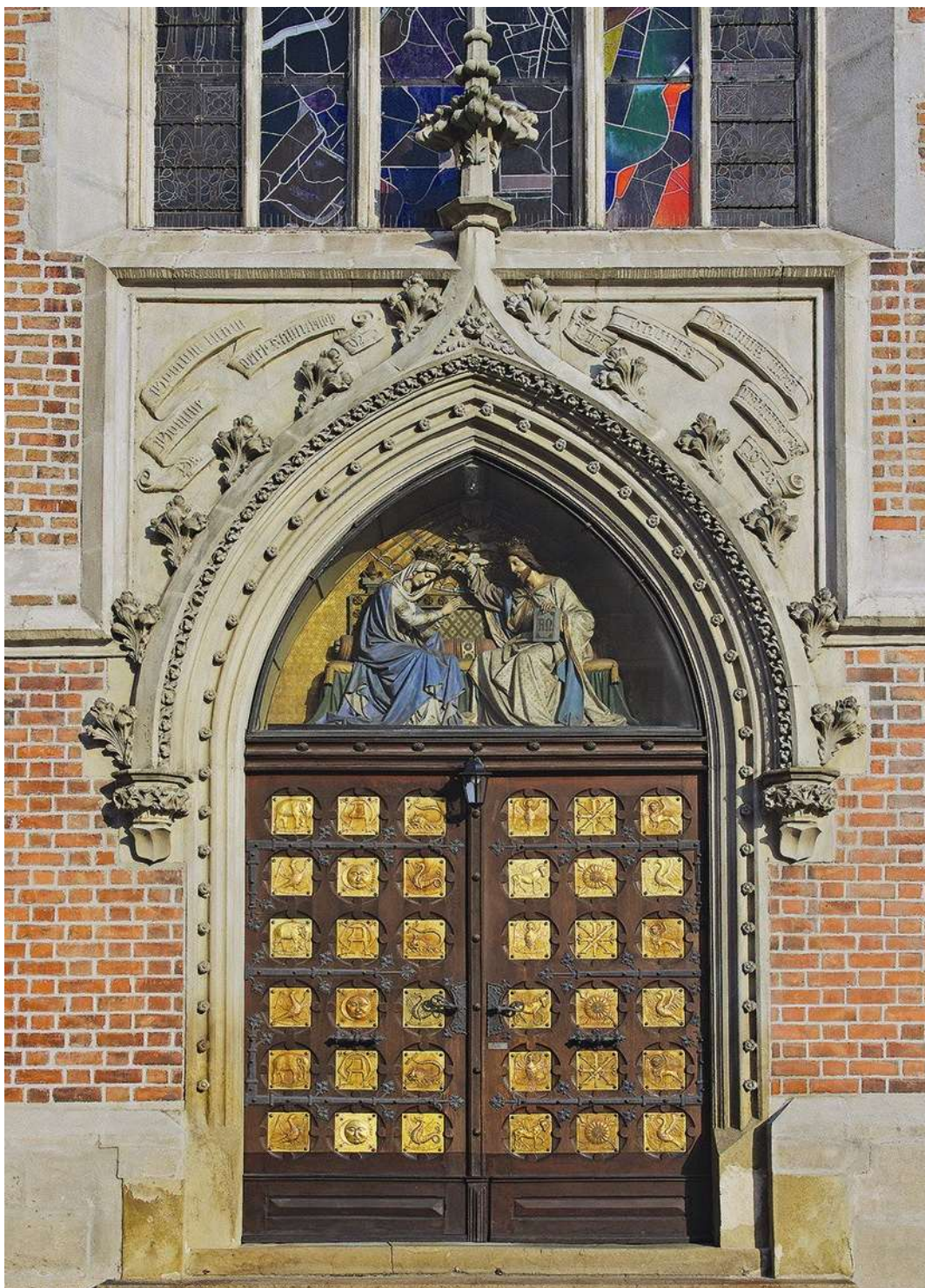
Vstupní portál a vrata baziliky
